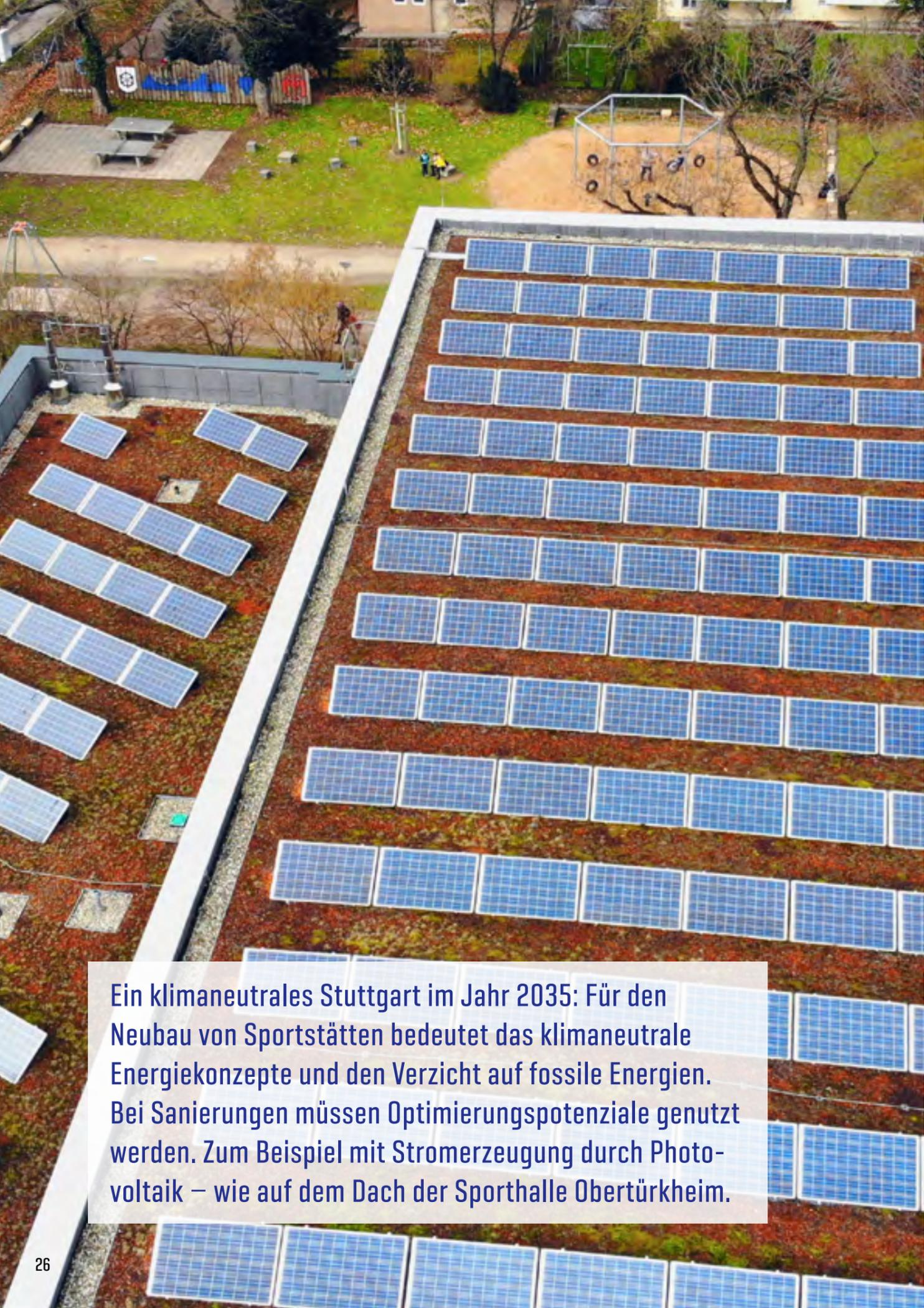
Ein klimaneutrales Stuttgart im Jahr 2035: Für den Neubau von Sportstätten bedeutet das klimaneutrale Energiekonzepte und den Verzicht auf fossile Energien. Bei Sanierungen müssen Optimierungspotenziale genutzt werden. Zum Beispiel mit Stromerzeugung durch Photovoltaik – wie auf dem Dach der Sporthalle Obertürkheim.
