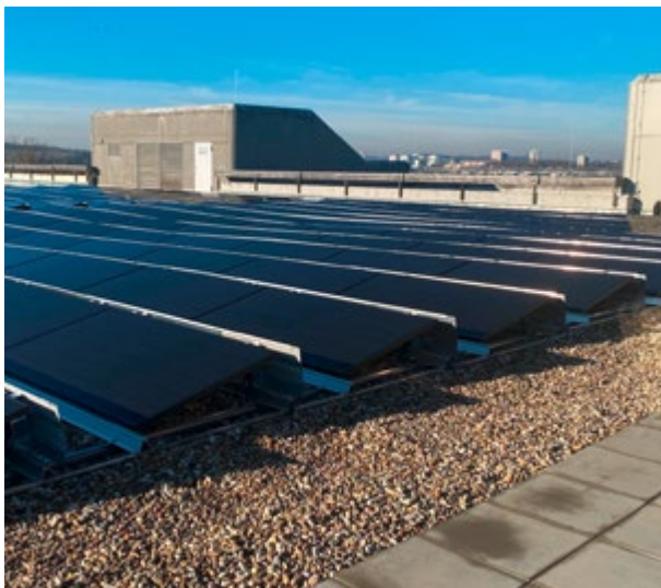
Sheddach + PV-Anlage
