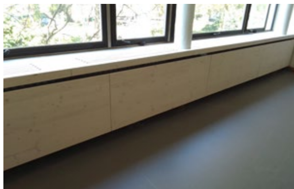
Prallschutz in der Turnhalle der Pfaffenwaldschule
