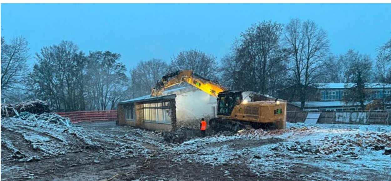
Abbruch Pavillon 2 und 3
