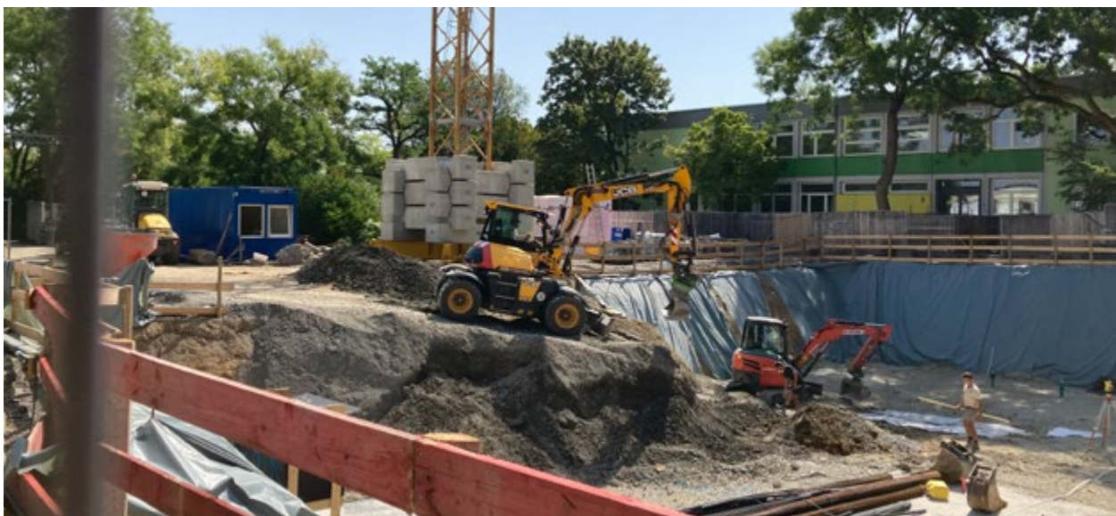
Aushub der Baugrube
