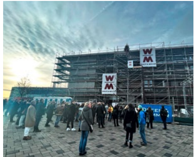
Richtfest im Januar 2024
