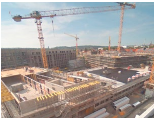
Blick auf die Baustelle vom Dach des gegenüberliegenden Quartiersparkhauses im August 2023
