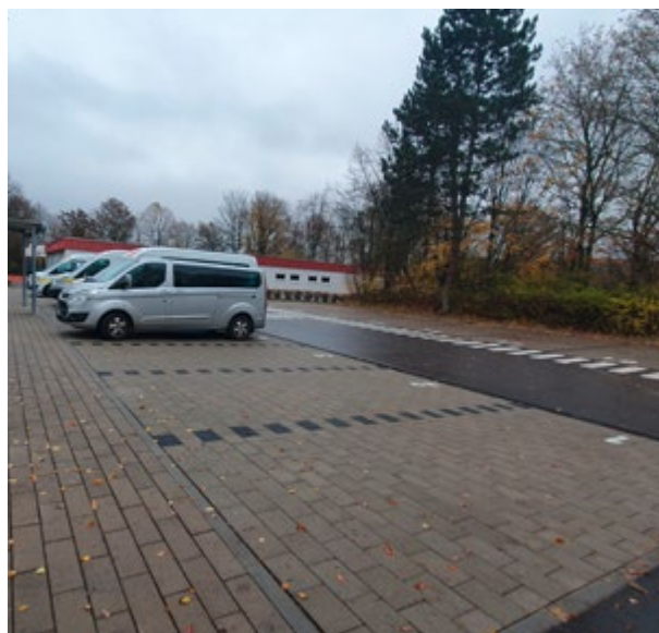
Fertigstellung neuer Parkplatz
