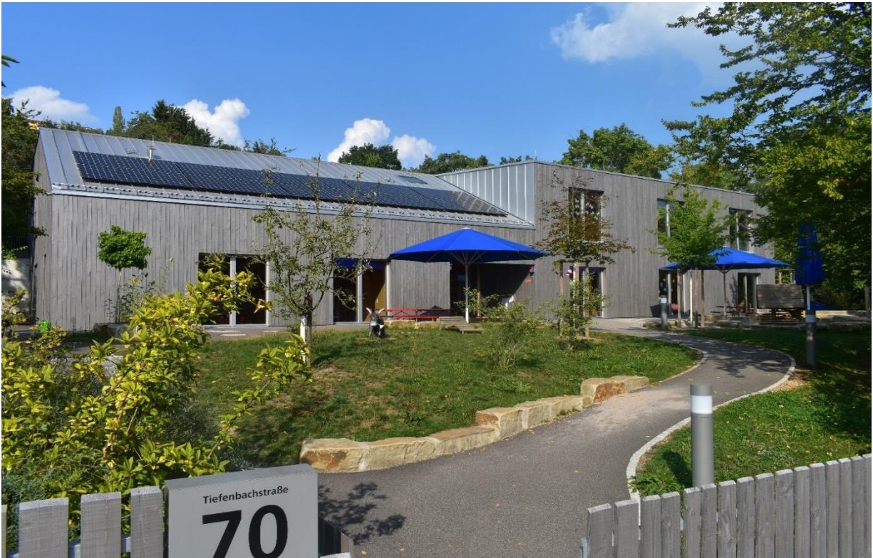
1 Außenansicht auf unsere Kita. Foto Stadt Stuttgart
