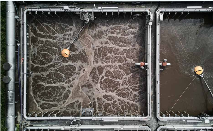
Im Projekt Emission Control von Variolytics werden Treibhausgase in Kläranlagen durch Optimierung der biologischen Stufe mittels innovativer Messtechnik reduziert.
