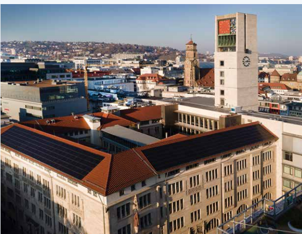
Stuttgarter Rathaus mit Photovoltaik auf dem Dach
