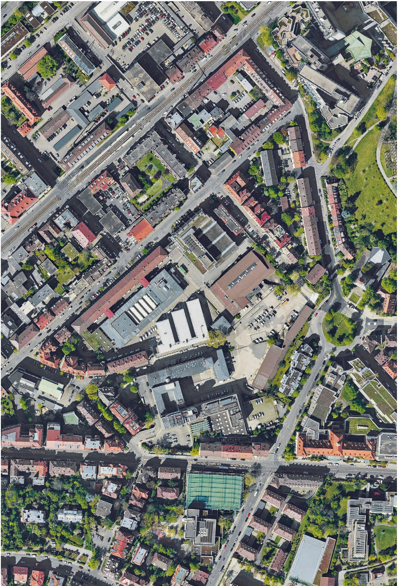
Abb. 19. Luftbildaufnahme des Projektgebiets © EnBW
