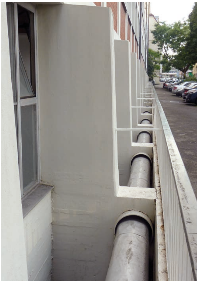
Abb. 12. Niveausprung zwischen Gebäude 10 und Stöckachstraße © LHS
