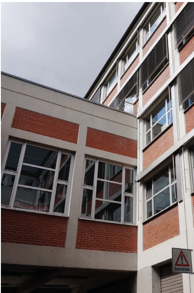
Abb. 13. Brückenbauwerk als Verbindung zu Block B © C4C
