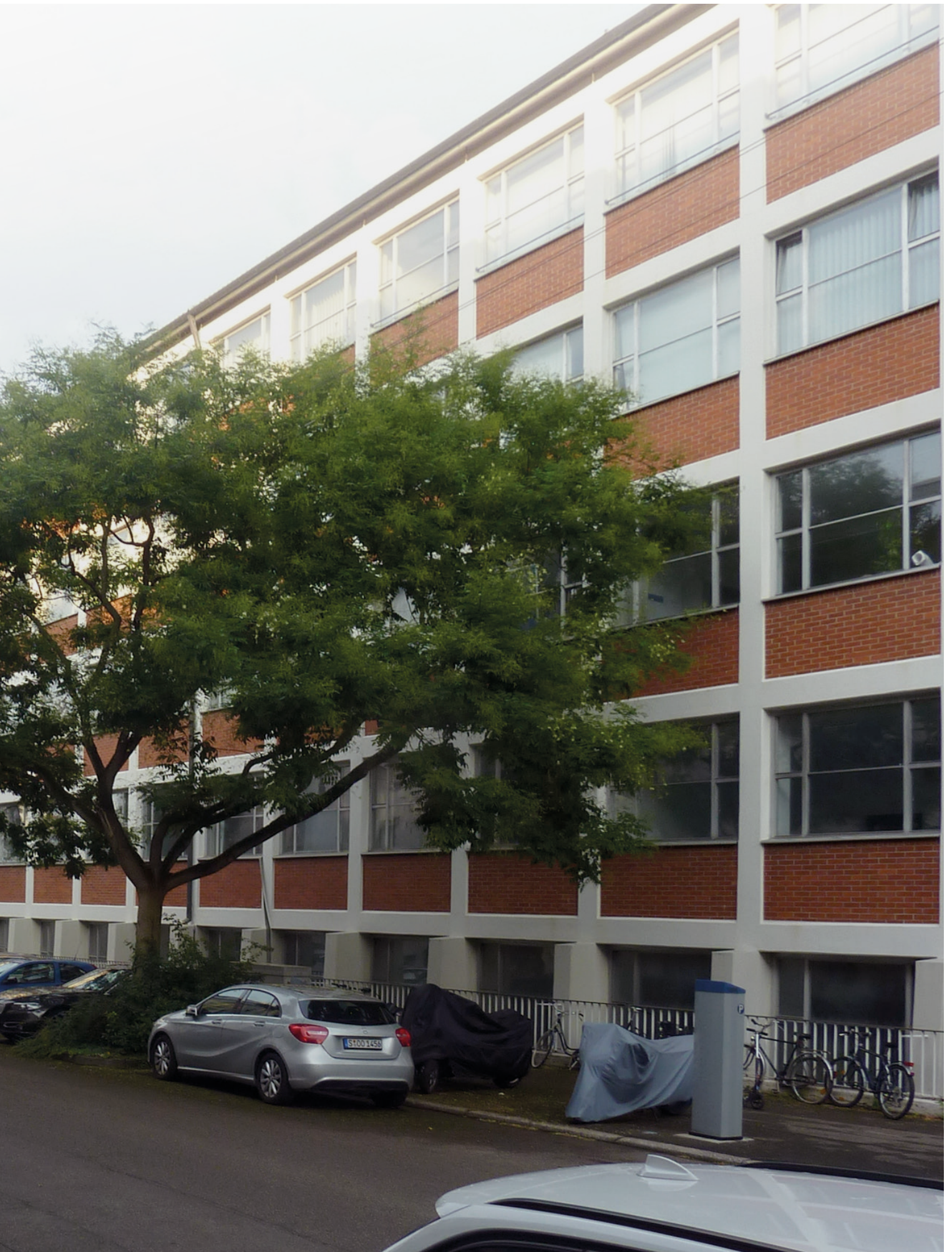
Abb. 6. Aufnahme von der Stöckachstraße auf Gebäude 10 © Landeshauptstadt Stuttgart
