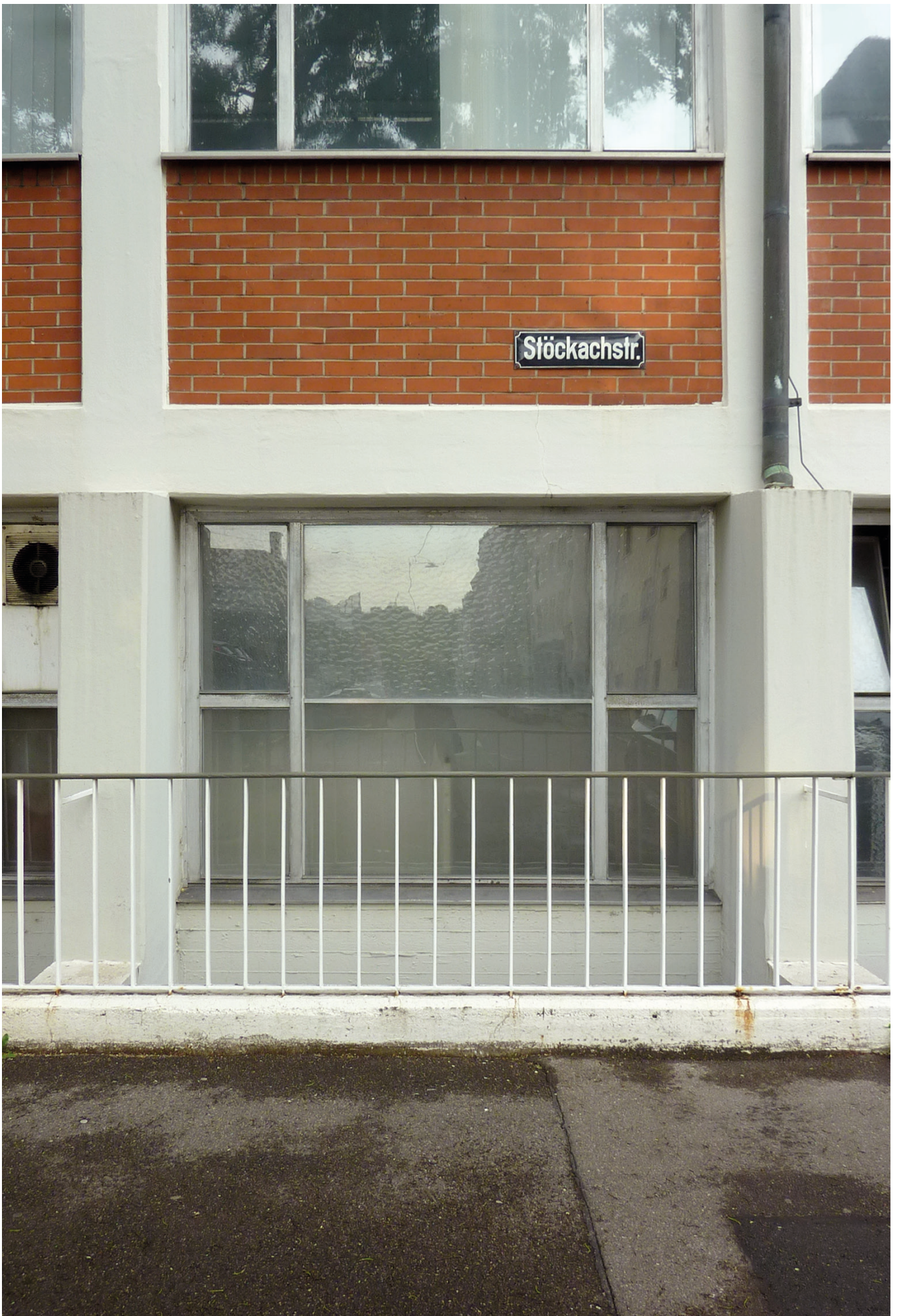
Abb. 18. Detailaufnahme Gebäude 10 © LHS
