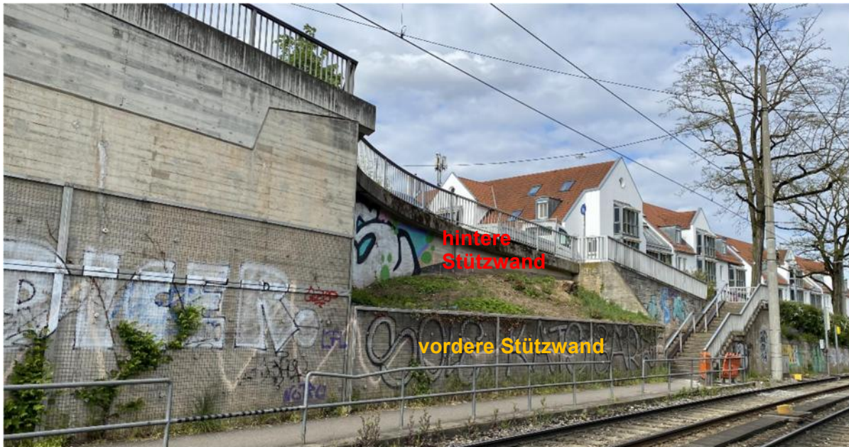
Abbildung 3: links; ehemalige Brücke, rechts „vordere“ und „hintere“ Stützmauer
