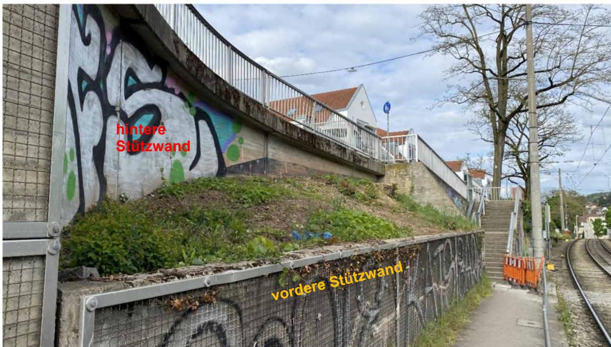
Abbildung 4: Blick auf „vordere“ und „hintere“ Stützmauer
