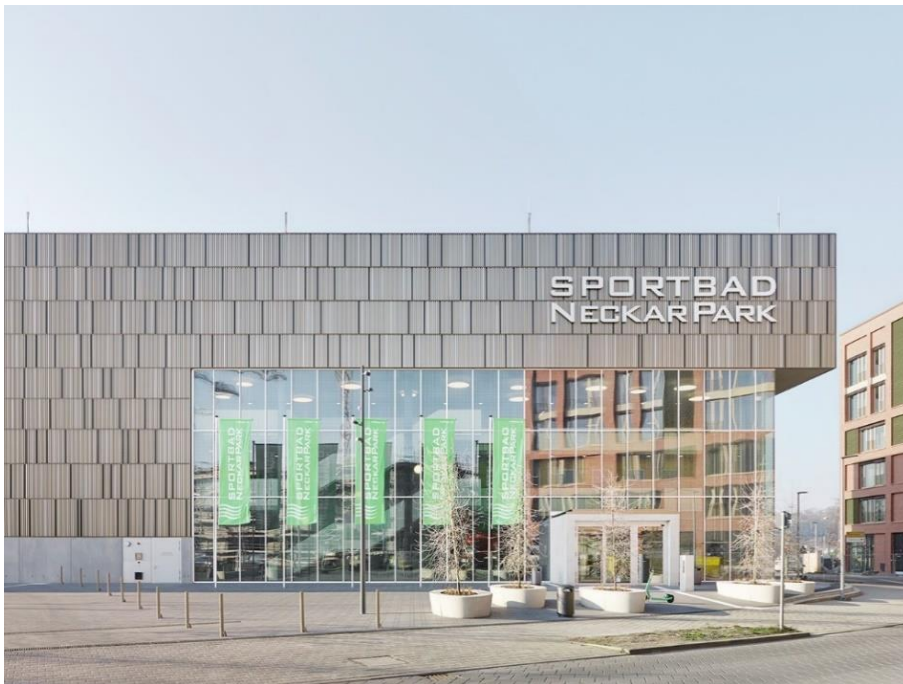
Bild 54 Außenansicht Sportbad Neckarpark (©Stuttgarter Bäder)
