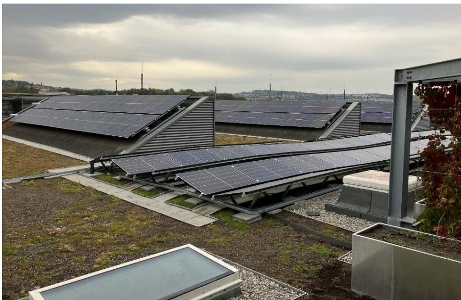
Bild 56 Gründach mit Photovoltaik des Sportbads Neckarpark (Quelle: Amt für Umweltschutz)
