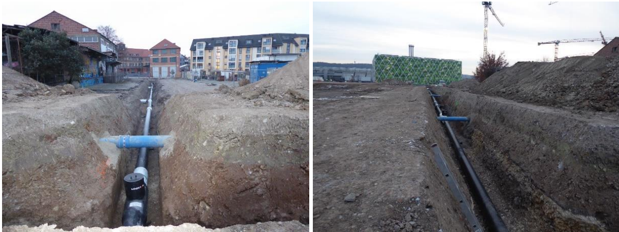
Bild 83 Neckarpark Stuttgart: Bau des Nahwärmenetzes (Quelle: LHS)
