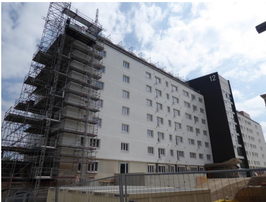
Bild 86 Baufortschritt am Bau 2 (Quelle: LHS)
