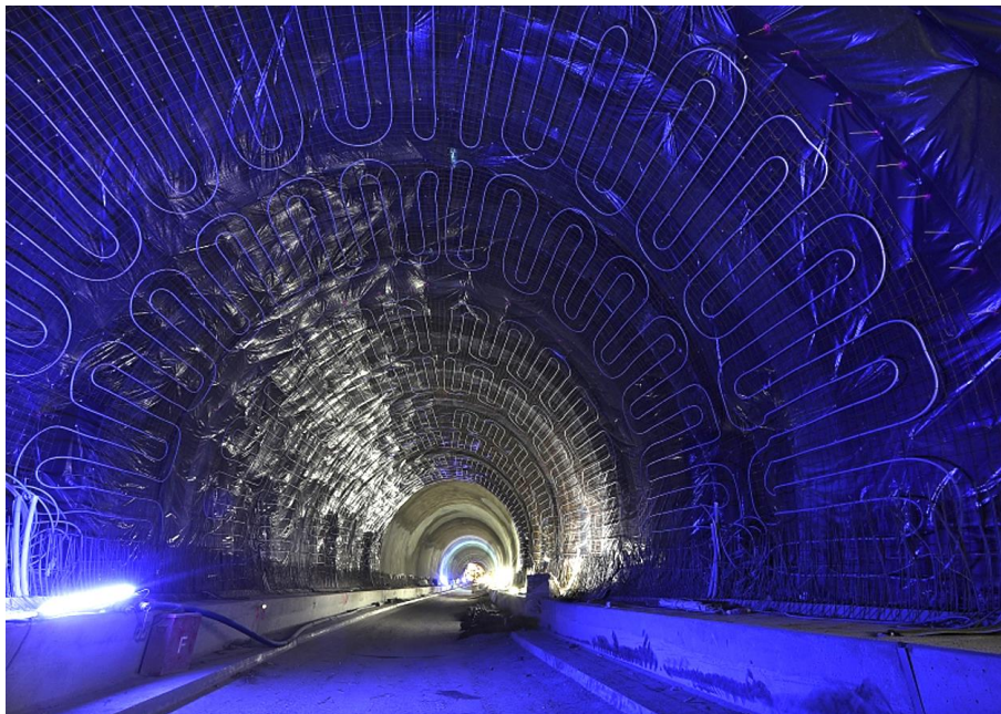
Bild 51 Absorberleitungen in der Tunnelschale (Quelle: Universität Stuttgart)
