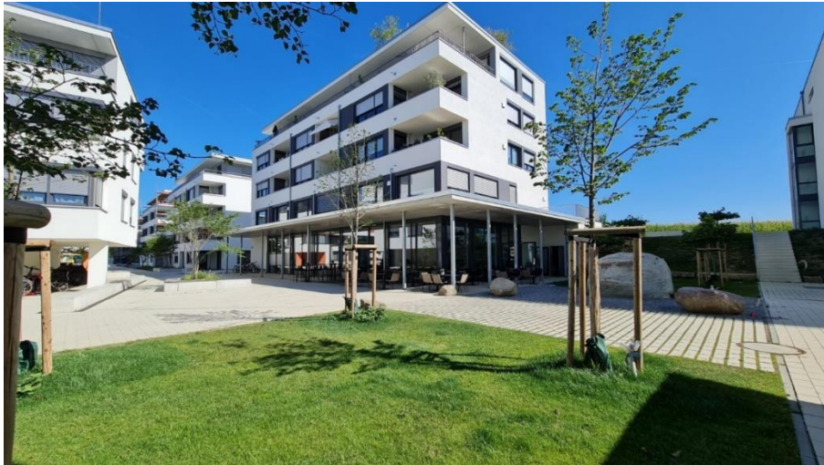
Bild 87 Baufortschritt im Demonstrationsquartier Überlingen, Stand 09/2022, (Quelle: Baugenossenschaft Überlingen eG)
