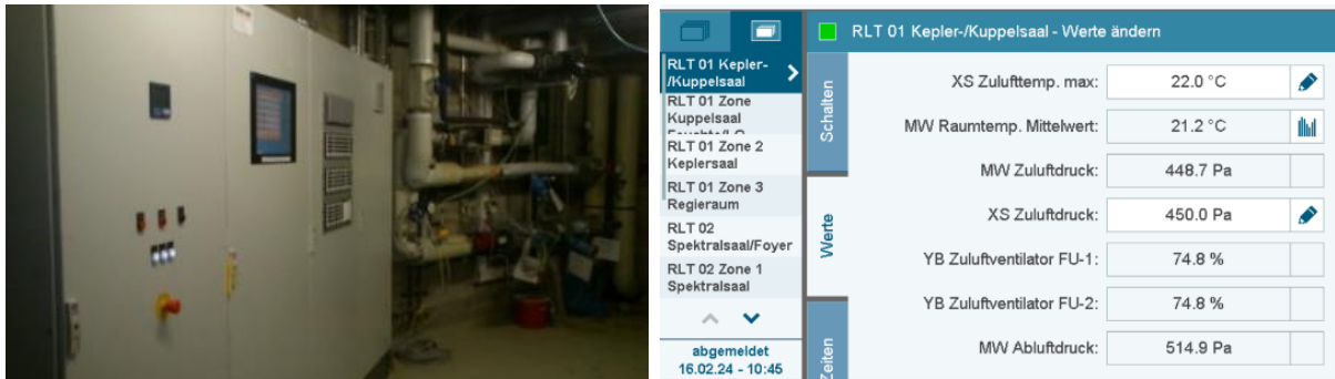
Bild 64 Gebäudeleittechnik MSR Zentrale mit dazugehöriger Grafik (Quelle: Amt für Umweltschutz)
