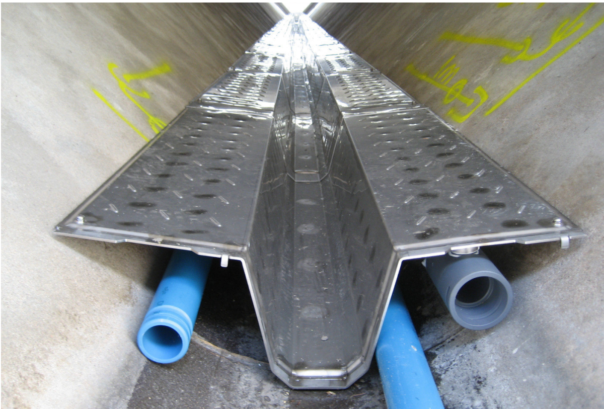
Abb. 4: Nachträglich einsetzbares Wärmetauschermodul im Kanal (RÜB Saarstraße, Bretten)
