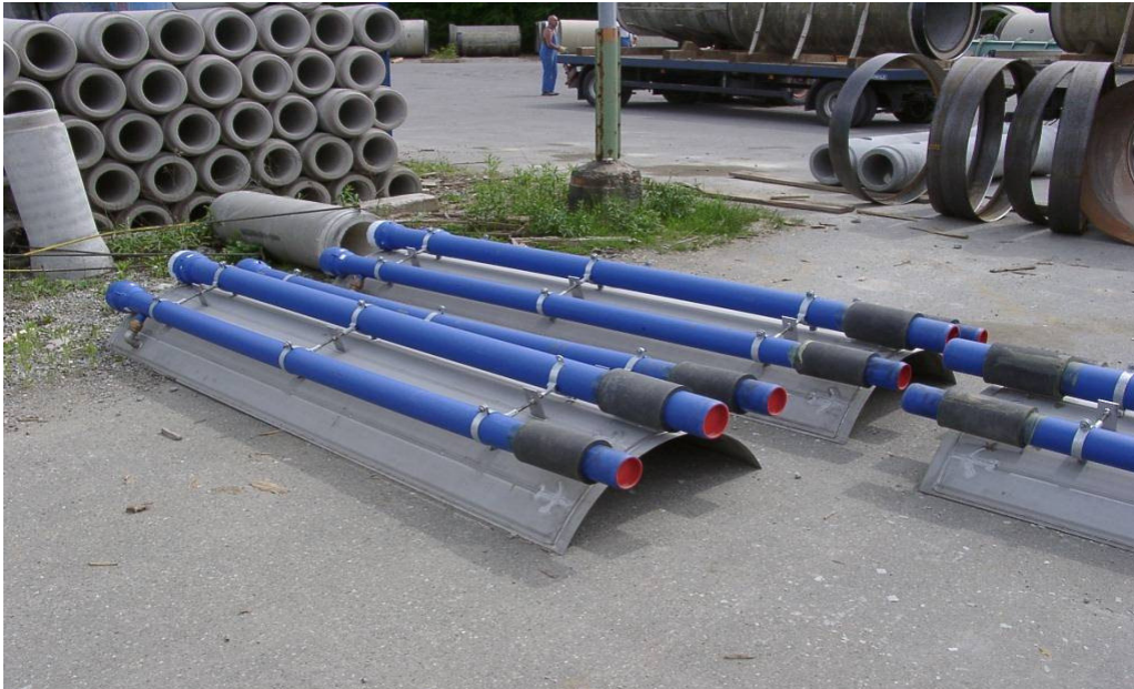
Abb. 5: Vorgefertigter Wärmetauscher im Betonwerk vor dem Einbringen in die Schalung (aus: /2/)
