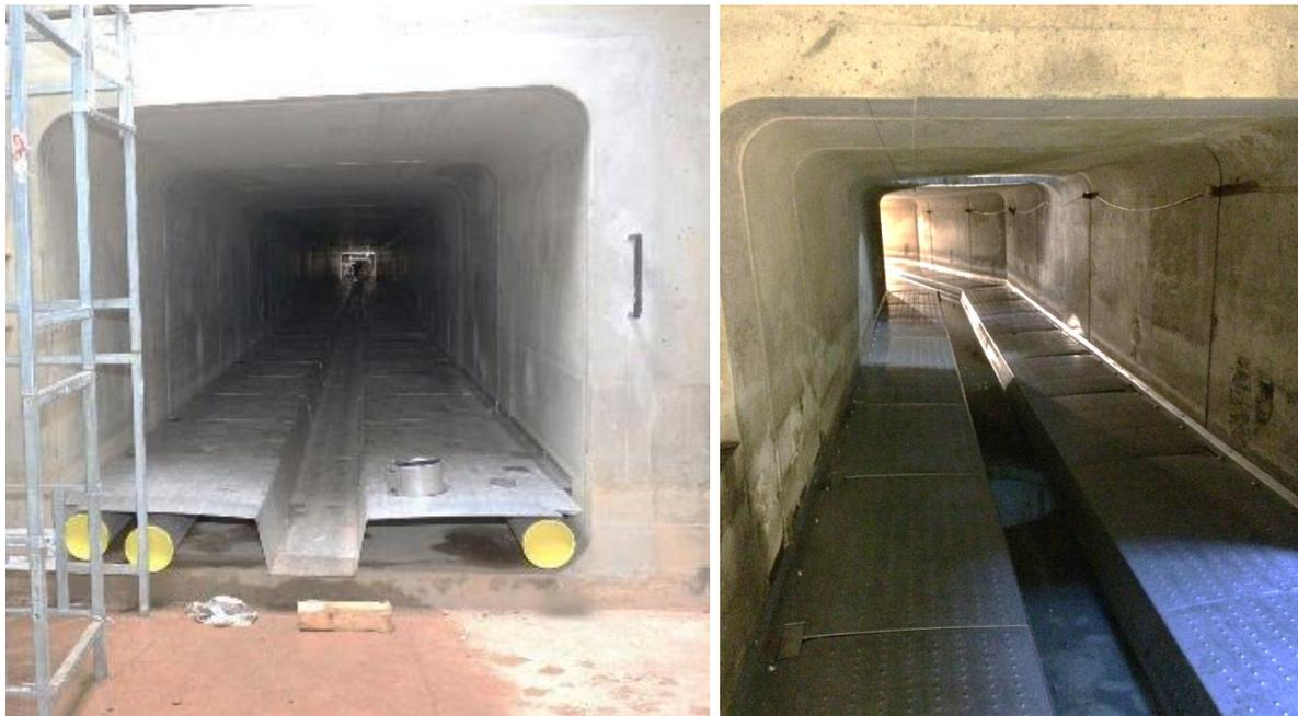
Abbildung 26 In Abwasserkanal eingebrachte Wärmetauscher
